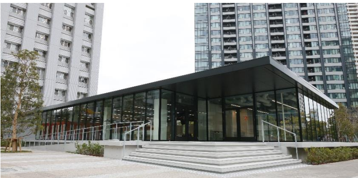
製図室棟 [ARCHITECTURE PLAZA] 外観
